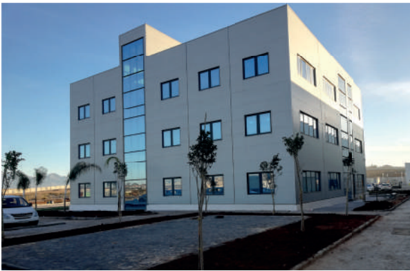
Metalstructure, Edifício Empresarial Argélia
