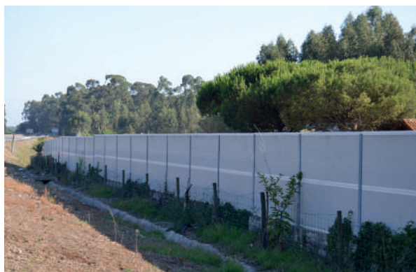
Barreira Acústica Portugal
